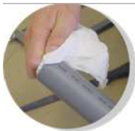
❸ Eliminar las virutas producidas por el corte y el bisel.
