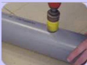
❶ Marcar el punto donde taladrar sobre la generatriz del tubo y taladrar perpendicularmente al tubo un agujero del mismo diámetro que el tubo a injertar.
