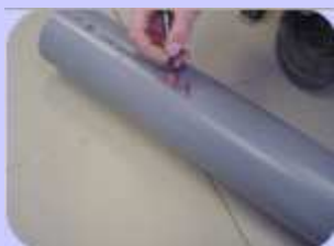
❶ Marcar el punto donde taladrar sobre la generatriz del tubo y taladrar perpendicularmente al tubo un agujero del mismo diámetro que el tubo a injertar.
