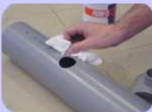
❸ Limpiar la superficie con limpiador para PVC Ferroplast.
