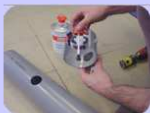
❹ Pegar el injerto a tubo con adhesivo Ferroplast.
