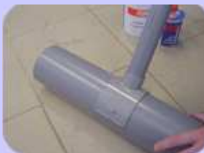
❹ Pegar el injerto a tubo con adhesivo Ferroplast.
